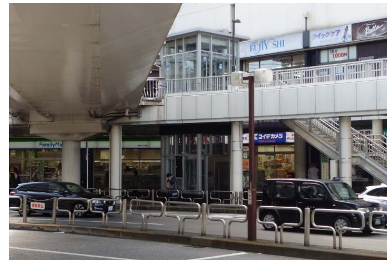
◆2014年度に完成した町田駅前デッキのエレベーター
